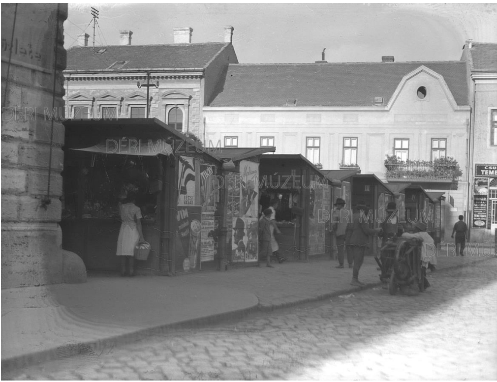
DÓSA NÁDOR TÉR 3. EREDETI HOMLOKZAT
