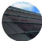
BRAMAC indach napelem a magastetőn
