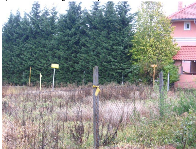
Építési területen lévő gázvezeték nyomvonala
