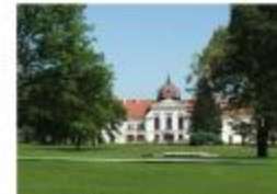
felújítás után / after rehabilitation
