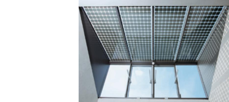
Die Sheddachflächen wurden zusätzlich mit Photovoltaikmodulen bestückt
