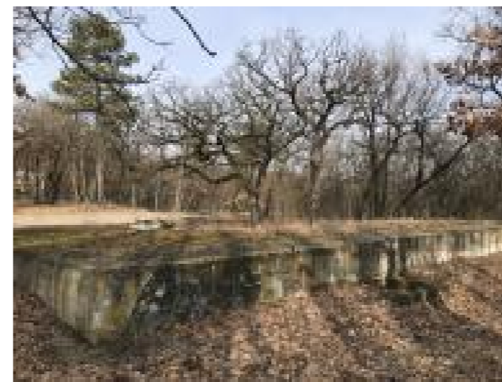
Átriumos épület alap-maradványai
